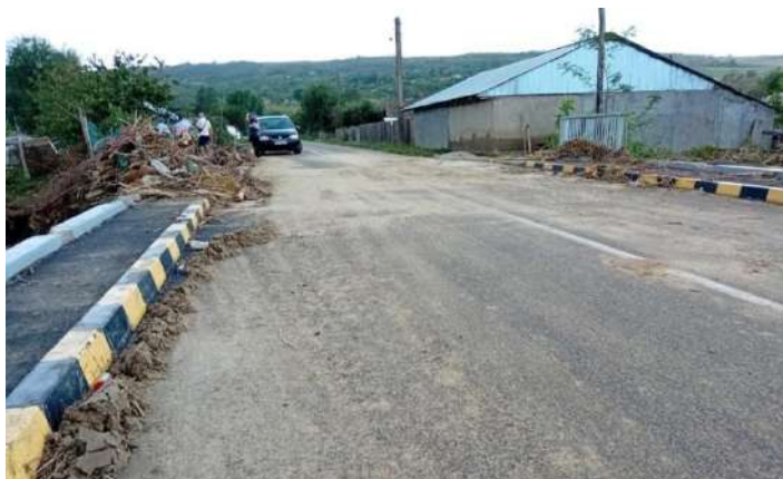
Fig. nr. 3. Aluviuni și resturi vegetale rămase după viitură. Pereții casei păstrează nivelul maxim al apei atins în ziua precedentă. Satul Lungești, jud. Galați (15.09.2024)
