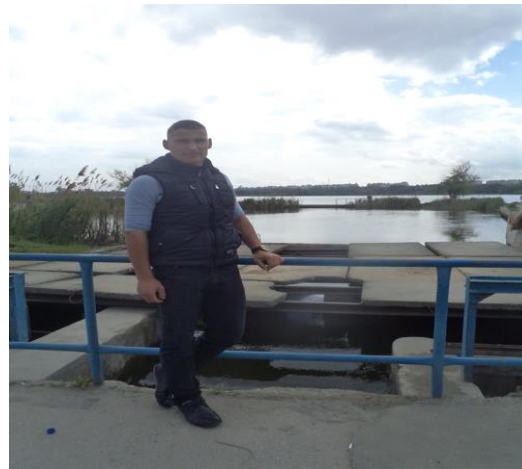
Fig. nr. 9. Canalul de legătură dintre Lacul Tăbăcărie și Marea Neagră
